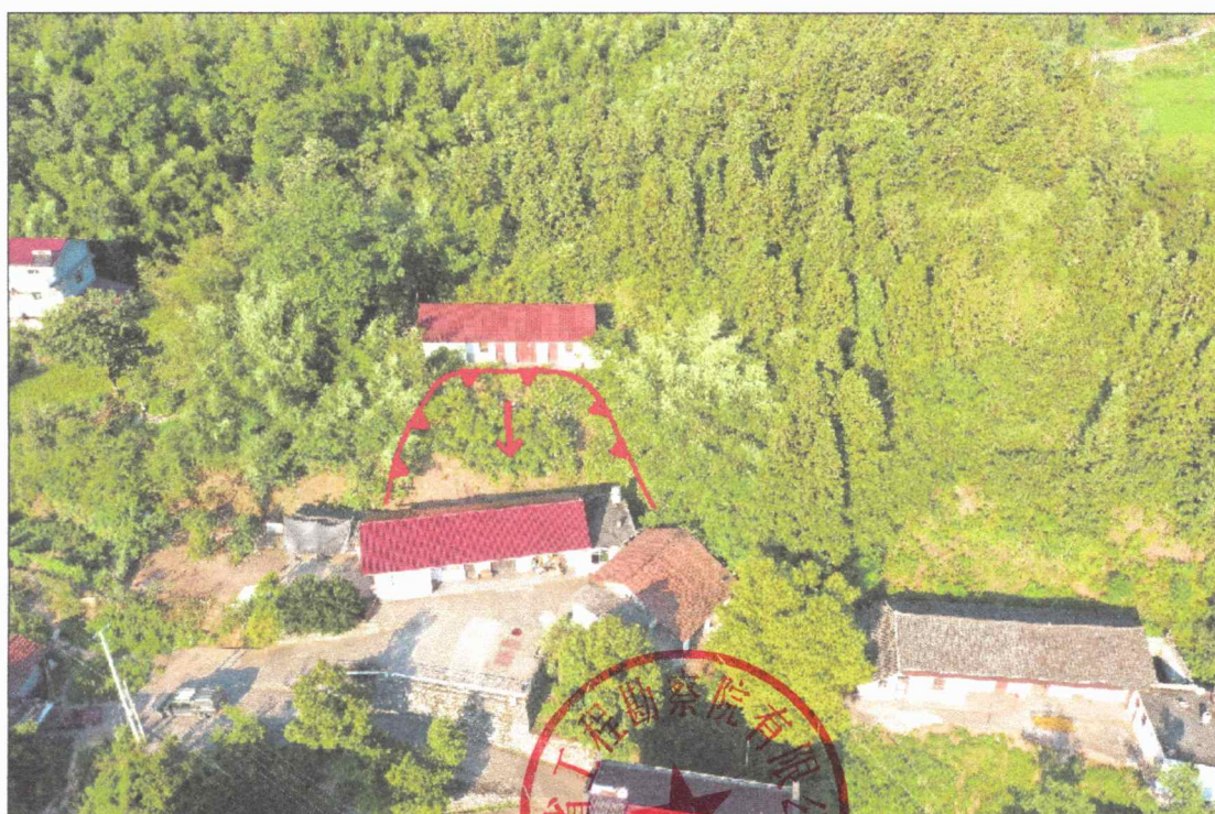
图2 滑坡全景照（坡向259°）
