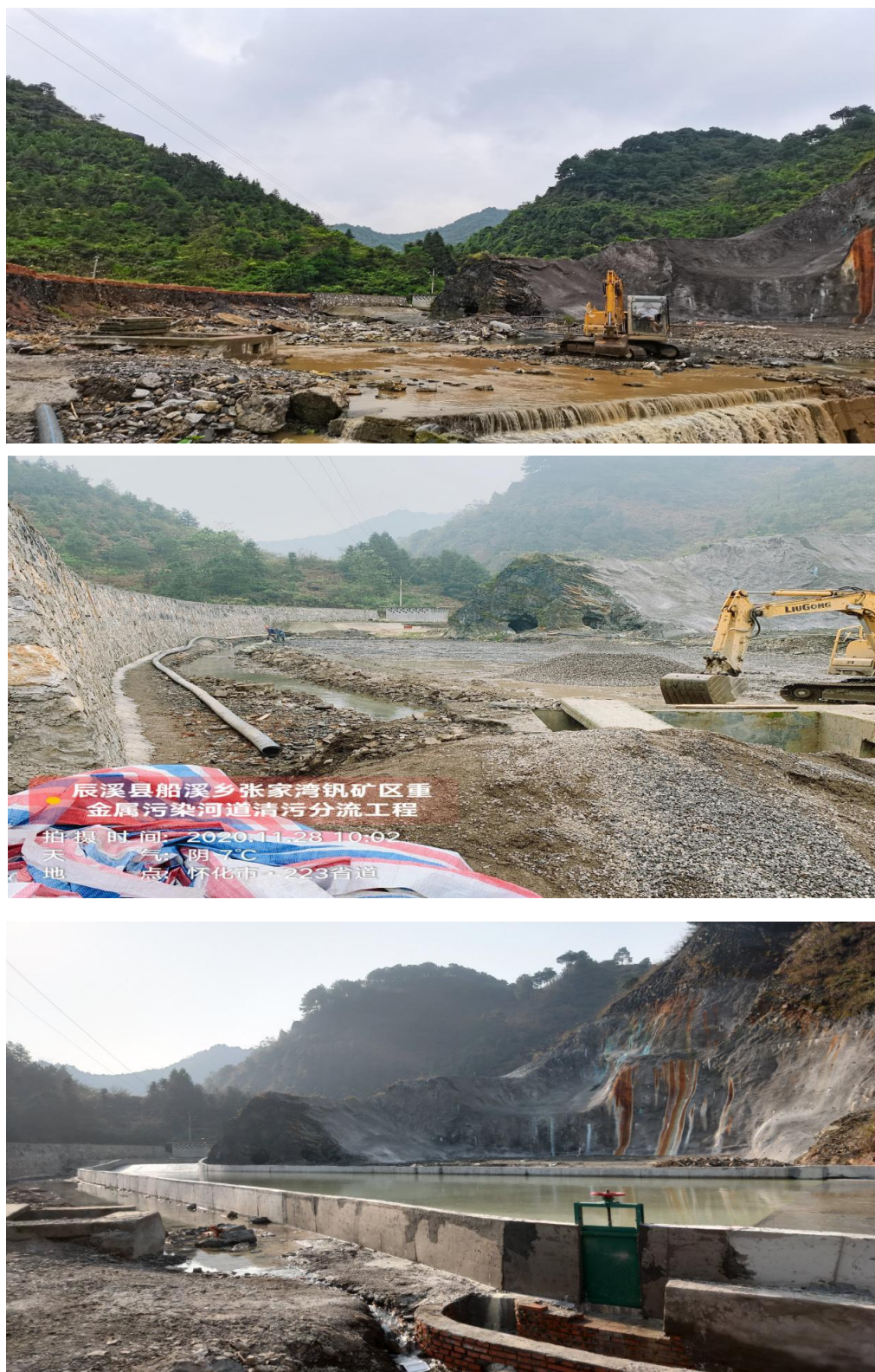
图 6.2-5 船溪乡张家湾区域清污分流工程新建蓄水池
