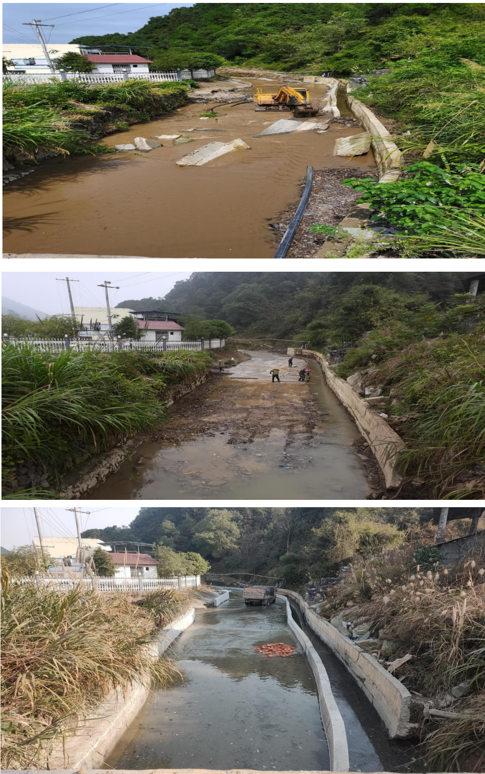
图 6.2-2 船溪乡张家湾区域清污分流工程（K1+300 下游段）
