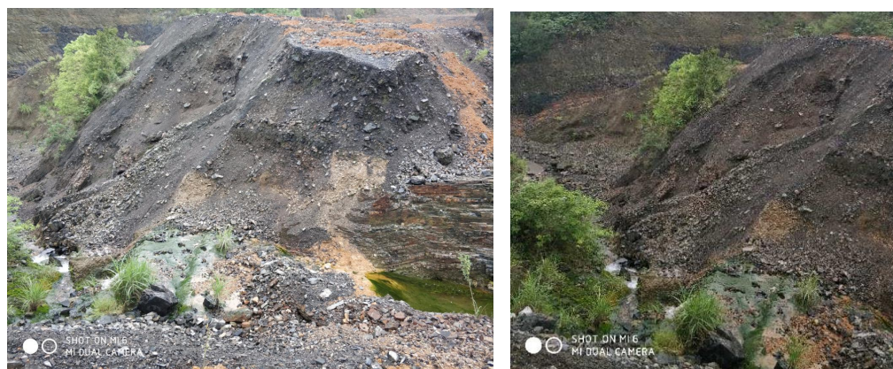
▲张家湾矿区北侧遗留废渣
